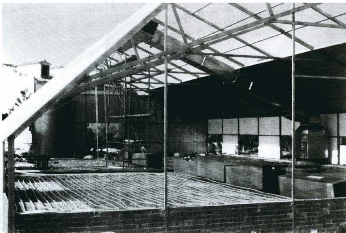
Foto 5: Paret nord aïllada.
